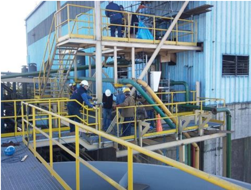
Montajes de estructuras
