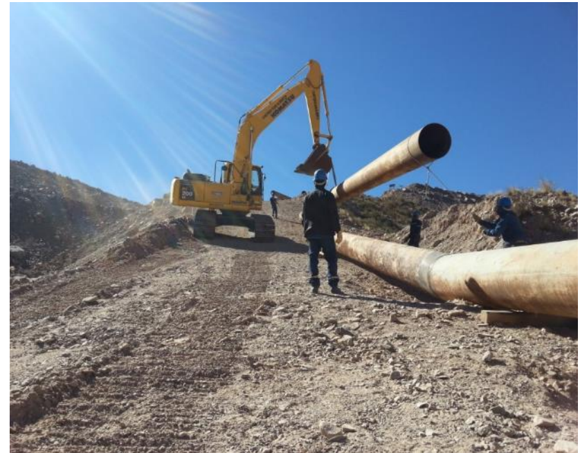
Montaje de piping 24" y 36"
